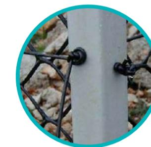
Mise en place des fils de tension sur les poteaux
