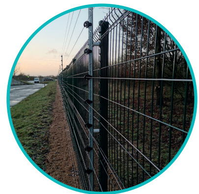
La clôture détectrice peut compléter une clôture existante
